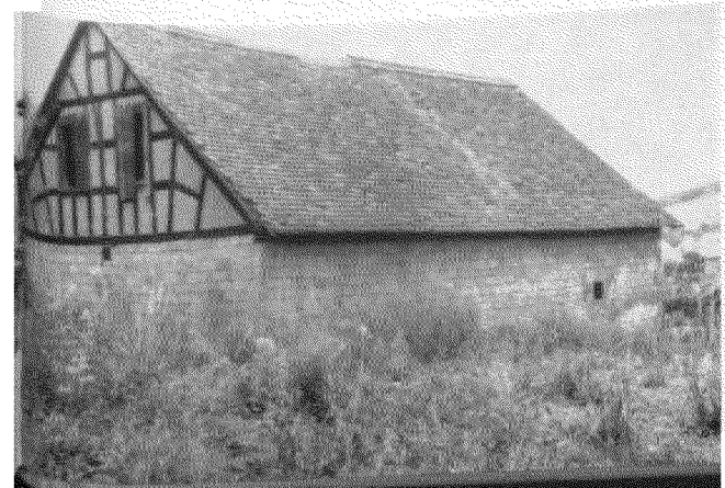
Abb. 16 Restgebäude vom ehemaligen Eisenhammer
