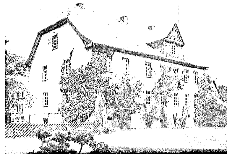
Die Wilhelmsburg zu Hichenbach (jetzt Amtsgericht)
