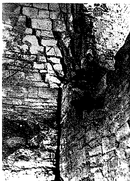
Abb. 71. Spalt zwischen Längs- und Querwand in K 2
