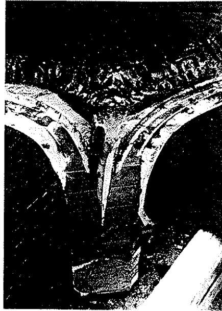
Abb. 83. Mittelpfeiler M 3. Reichssaal
