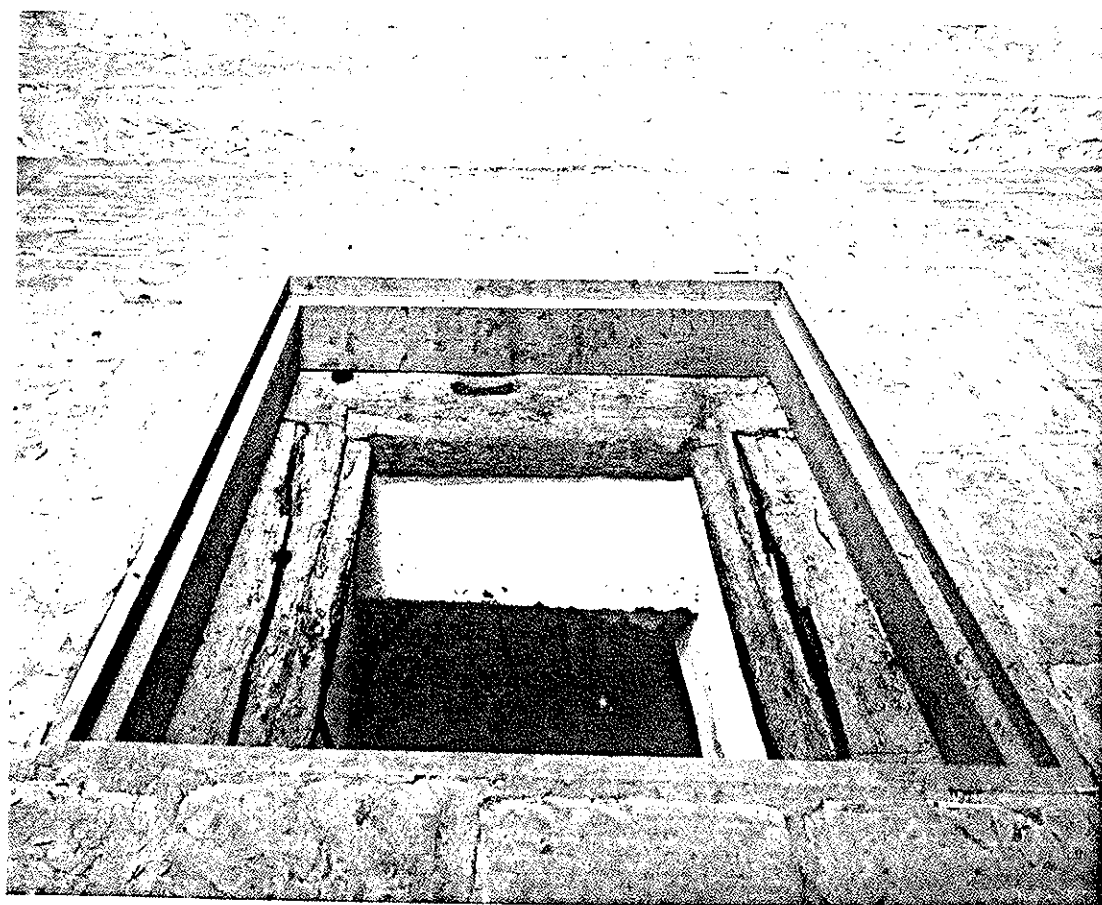
52 Rheda, Doppelkapelle, Öffnung im Fußboden. Die Rahmenhölzer zeigen Zapfenlöcher (für ein Geländer?) und den Falz für eine Abdeckung
