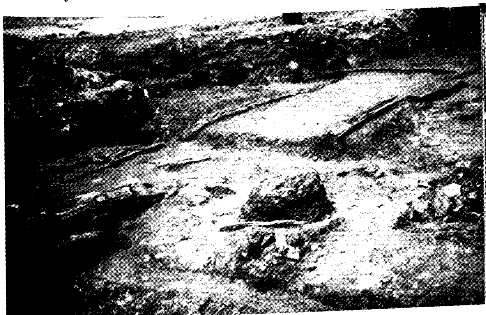
Obr. 37. III. nádvoří. Srubová stavba u západního portálu sv. Víta. Pohled od jihovýchodu.
