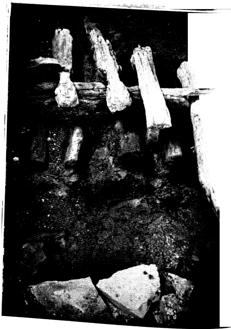
Obr. 17. III. nádvoří. Kotvová konstrukce dřevěných roštů uvnitř navázek druhého opevnění. Pohled od jihu.
