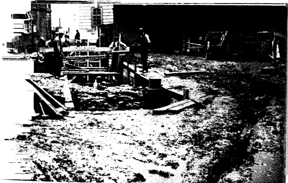
Obr. 28. Nádvoří „Na baště“ (IV). Zděný západní svah druhého příkopu Přemysla Otakara II. Pohled od severovýchodu.
